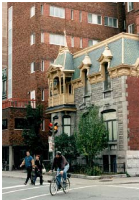
L'intersection des rues Milton et Hutchison montre la diversité des bâtiments de la Communauté Milton Parc: au coin, la maison McKenna, construite en 1891, et l'immeuble voisin de sept étages, bâti en 1948. Photo: Rosalind Cook
